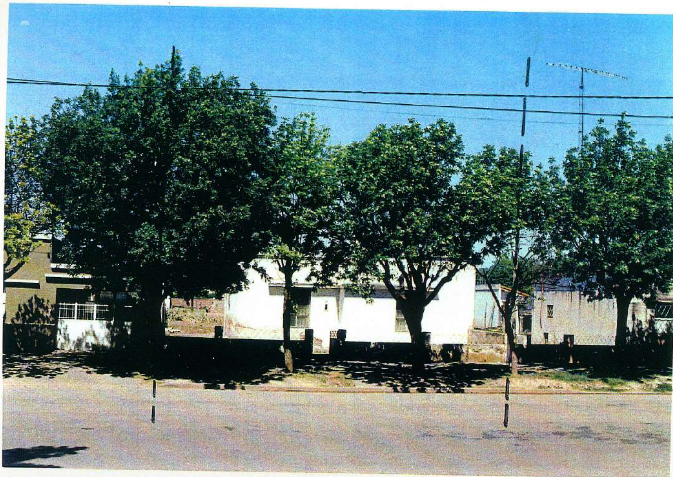
VISTA DESDE AV. SAN MARTIN
