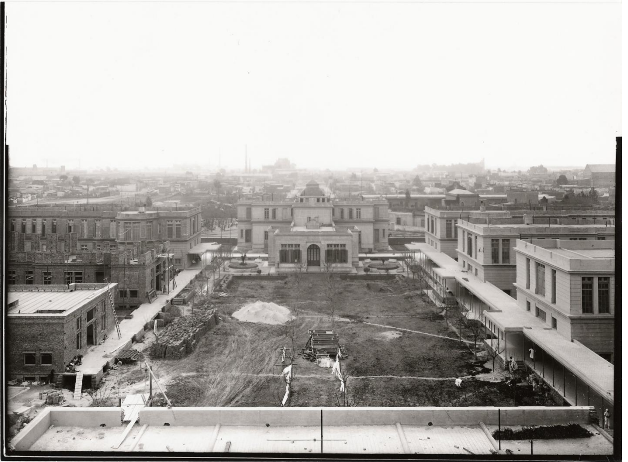
Obra en construcción – vista pabellones
