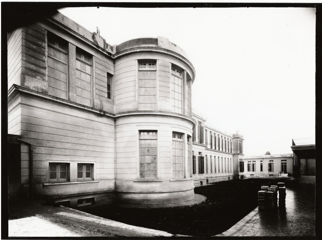
Vista obra en construcción – calle Urquiza ala este
